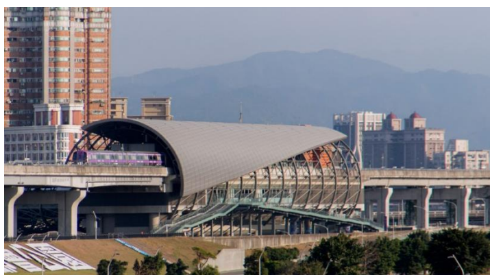
機場捷運 A2 站
