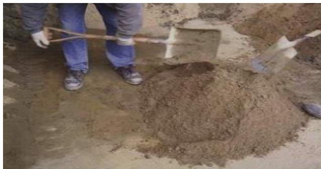
傳統工地，工人依據經驗和感覺， 將砂和水泥於地面加水拌和
