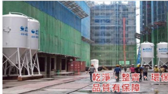
使用 泰固美特耐 產品的工地
