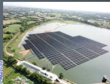
桃園埤塘太陽光電設施
