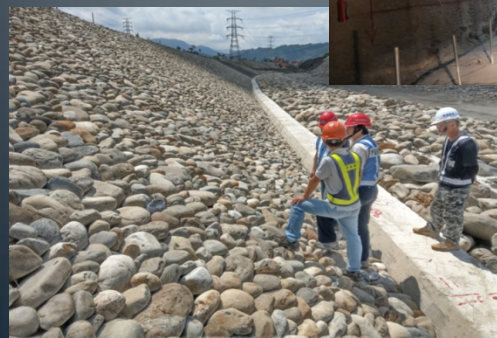
鳥嘴潭人工湖堤防工程
